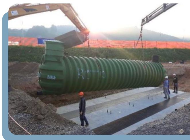
Photo 4 : Installation du réservoir
