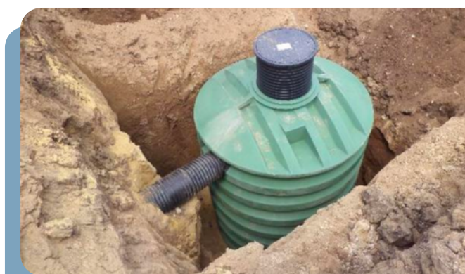
Photo 6 : La cuve installée
