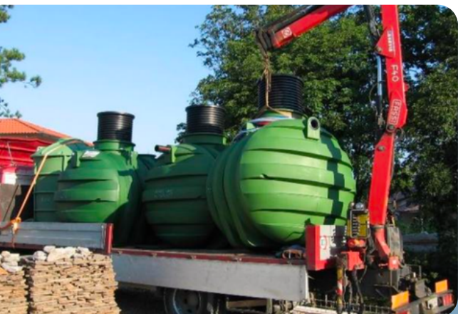
Photo 1 : Transport et déchargement correct
