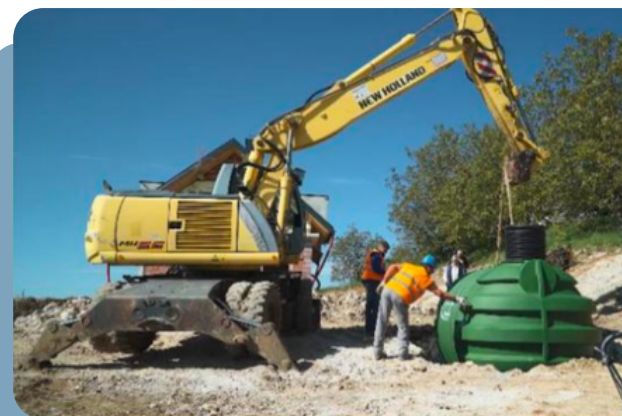
Photo 3 : Installation du réservoir
